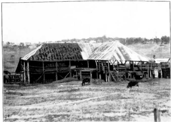
Die baufälligen Schuppen, vor denen ein paar Kühe grasen, konnte ich unmöglich für die Mine halten. (S. 174.)
